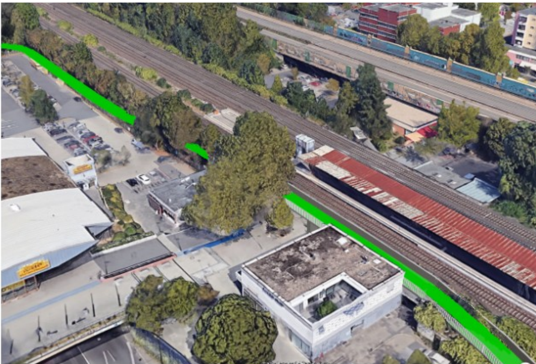
Am Rand des P+R-Platzes hoch über den Eingang des S-Bahnhofs Garath
